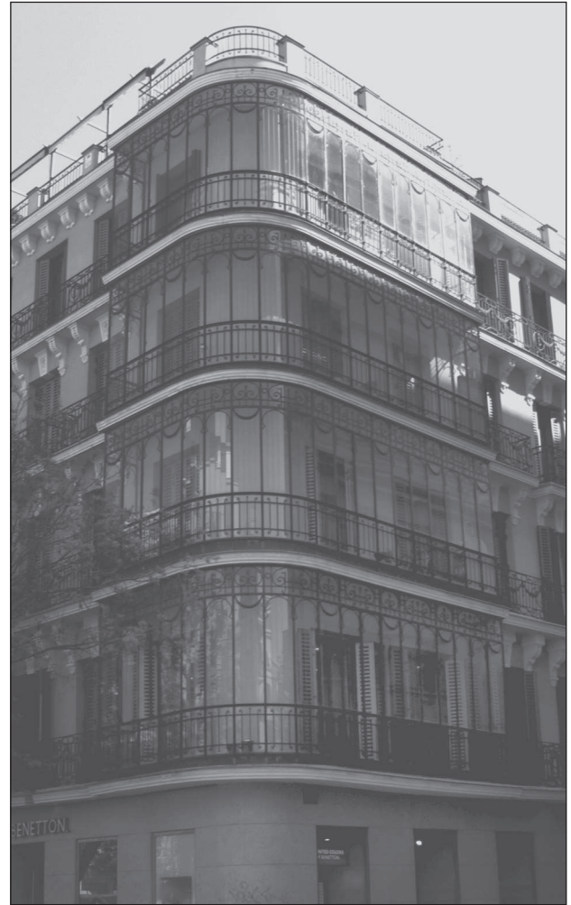
15. Francisco de Cubas, kamienica Francisca Picazo, 1879-1880, fot. Autor, 2009 15. Francisco de Cubas, tenement house of Francisco Picazo, 1879-1880, photo: Author, 2009
