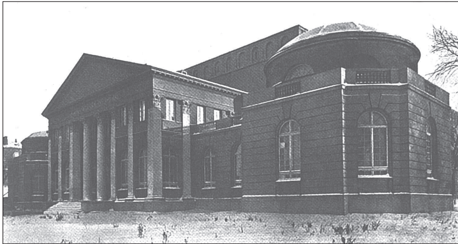
18. Gmach Państwowego Instytutu Geologicznego, widok od północnego zachodu. Wg „Architektura i Budownictwo”, 1934, nr 3, s.74
