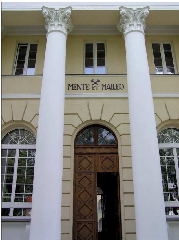
14. Gmach Państwowego Instytutu Geologicznego, portyk wgłębny w elewacji północnej. Fot. Autorka, 2009 14. Building of the National Geological Institute, deep-seated portico in the Northern elevation. Photo: Author, 2009
