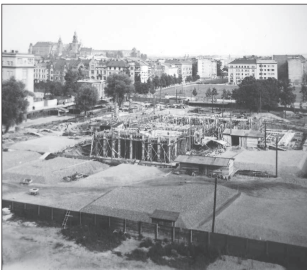
2. Prace budowlane, wznoszenie budynku, widok w kierunku Alej i ul. Piłsudskiego, Archiwum Muzeum Narodowego w Krakowie 2. Construction work, erecting of the building, view towards Avenues and Piłsudski street, from collection of National Museum Archives in Cracow
