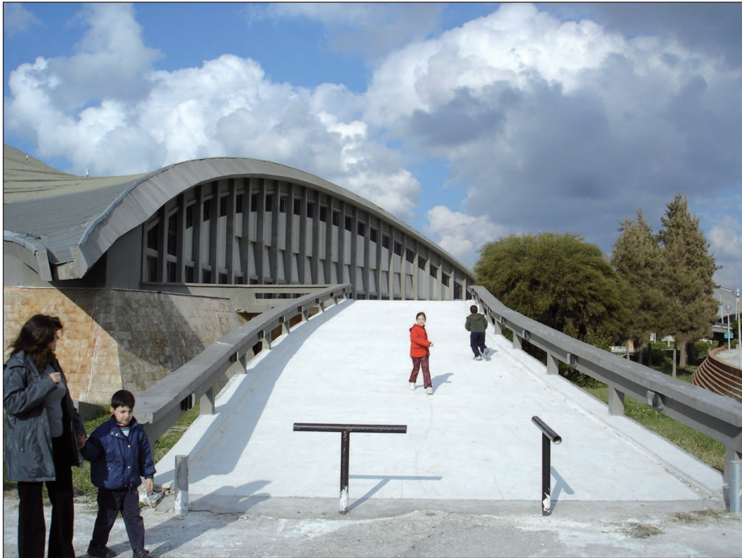
7. Widok na jedną z ramp prowadzących do głównego wejścia do hal sportowych. Fot. Autorka, 2006 7. View on the ramp leading to the main entrance of the sports halls. Photo: Author, 2006
