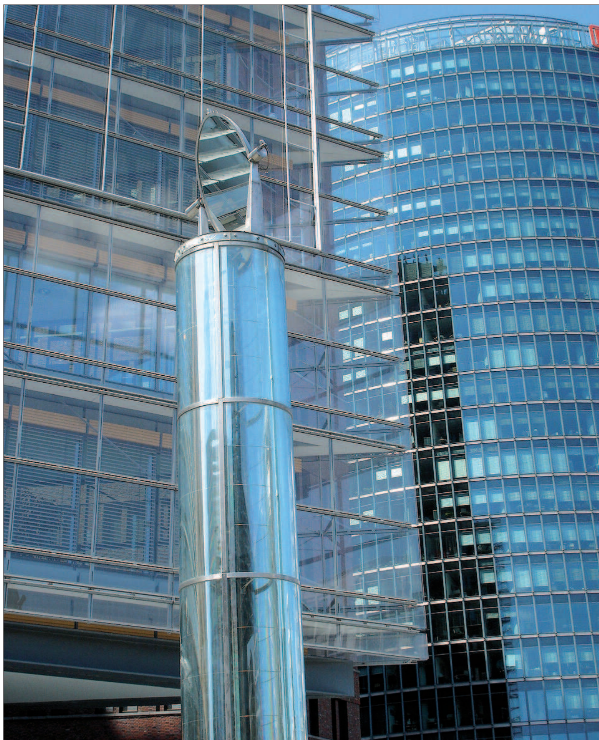
10. Technika | pozyskiwanie energii | system oświetlenia . Kolektor światła dziennego nad stacją podziemną metro, Berlin. Fot. W. Celadyn
