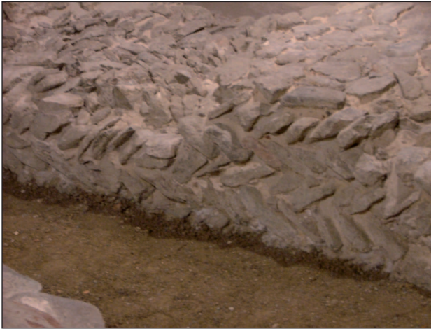
5. Katedra w Poznaniu, mur opus spicatum w masywie zachodnim. Fot. Z. Świechowski 2006-2010 5. Cathedral in Poznań, opus spicatum wall in Western edifice. Photo: Z. Świechowski 2006-2010
