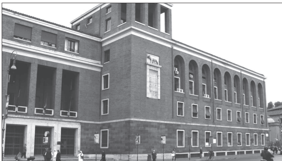
13. Cesare Valle i Ignazio Guidi, Palazzo del Governatorato, Rzym, 1936-1937, fot. F. Burno 2011 13. Cesare Valle and Ignazio Guidi, Palazzo del Governatorato, Rome, 1936-1937, Photo: F. Burno 2011
