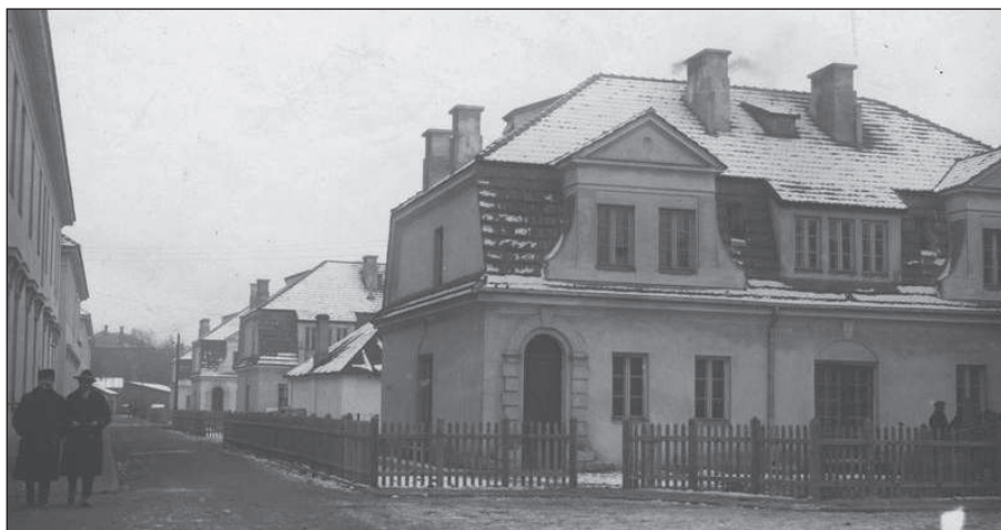
6. Zabudowa północnej części kolonii Staszica. Segmenty szeregowo. Po lewej stronie domy wielorodzinne przy 6 Sierpnia. NAC, sygn. 1-U-6613-1
