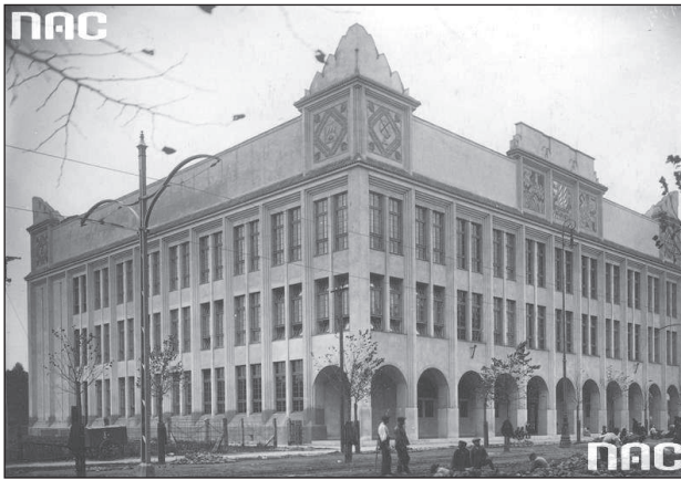
25. Pawilon Doświadczalny SGH, lata 20. XX w., arch. J. Koszyc-Witkiewicz. NAC, sygn. 1-N-3403
