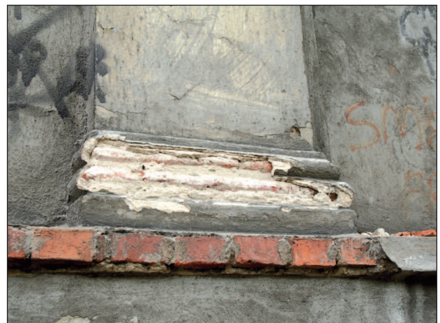
15. Bóżnica w Fordonie, elewacja pd., kształtki ceglane bazy pilastra, 2008 r.; fot. A. Jankowski 15. The synagogue in Fordon, the south elevation, the moulding brick base of the pilaster, 2008; photo A. Jankowski
