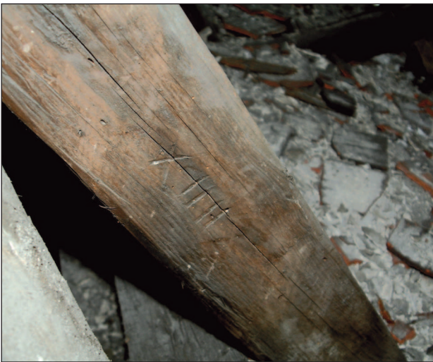
17. Bóżnica w Fordonie, więźba dachowa, ciesielski znak montażowy, cyfra „14”, 2008 r.; fot. A. Jankowski 17. The synagogue in Fordon, the rafter framing, the carpenter's mounting sign, figure “14”, 2008; photo A. Jankowski
