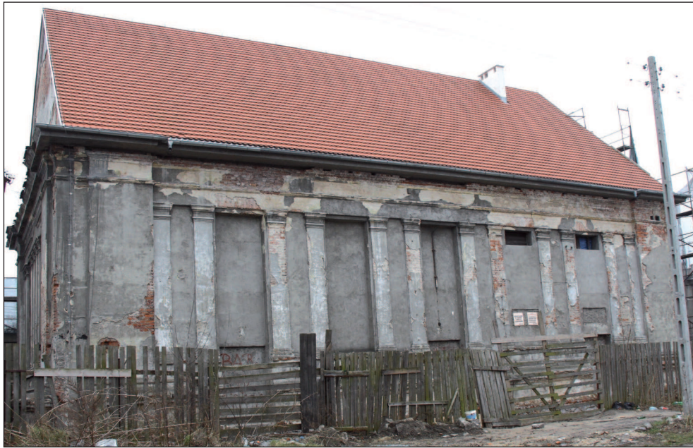
3. Bóżnica w Fordonie podczas remontu, widok od pn., 2011 r.; fot. A. Jankowski 3. The synagogue in Fordon during the renovation, view from north, 2011; photo A. Jankowski
