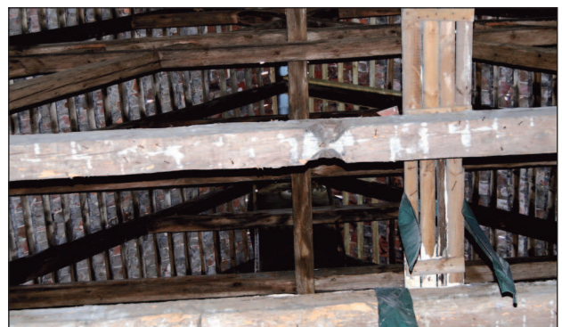
14. Bóżnica w Fordonie, wrąb w belce wiązarowej – ślad połączenia z konstrukcją bimah, 2008 r.; fot. A. Jankowski 14. The synagogue in Fordon, the truss beam, a north – a trace of a joint with a bimah construction, 2008; photo A. Jankowski
