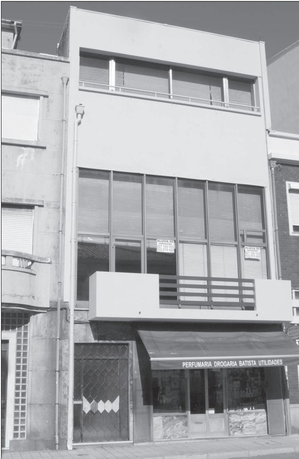
3. Viana de Lima, Casa da Rua Carlos Malheiro Dias (Dom przy ul. Carlos Malheiro Dias, Porto/Portugalia), 1941-1942, stan obecny. Przekształcenia: zamknięcie przestrzeni w układzie wejścia oraz przy ogrodzie górnego balkonu. Oryginalne pozostały elementy konstrukcyjne i materiały
