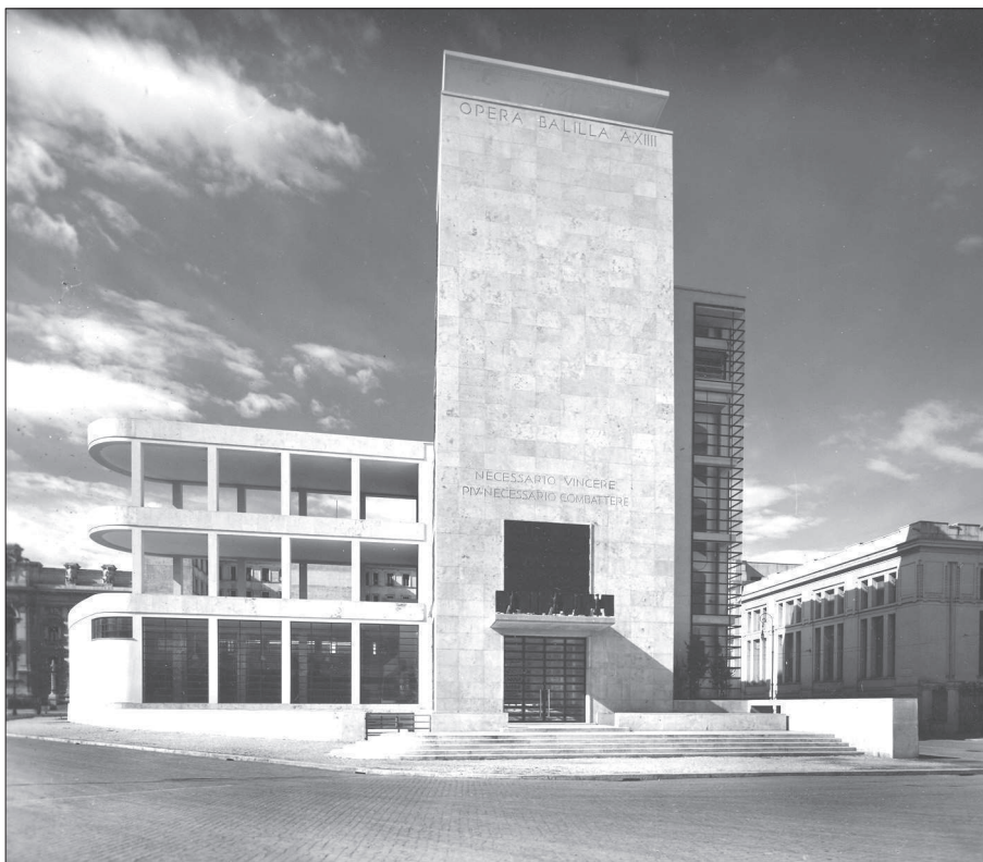
11. L. Moretti, Casa del Balilla in Trastevere, Rzym, 1932-1937, widok zewnętrzny w kierunku wejścia głównego, Archivio Centrale dello Stato, Rzym 11. L. Moretti, Casa del Balilla in Trastevere, Rome, 1932-1937, external view towards the main entrance. Archivio Centrale dello Stato, Rome
