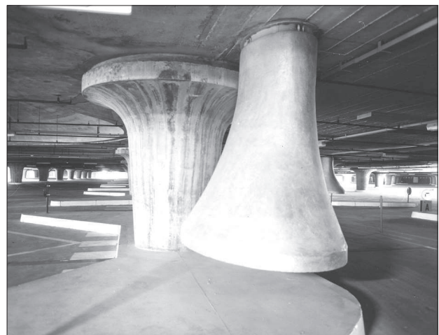
43. L. Moretti, podziemny parking Villa Borghese (1965-1972), filar w kształcie grzyba i czerpnie powietrza. Archivio Centrale dello Stato, Rzym
