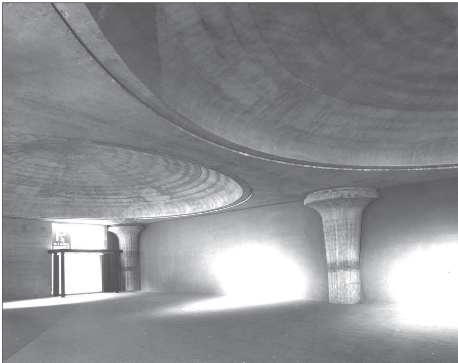
41. L. Moretti, Podziemny parking Villa Borghese (1965-1972), pierwsza kondygnacja podziemna z filarami w kształcie grzybów i odcinkowymi kopułami. Archivio Centrale dello Stato, Rzym 41. L. Moretti, Villa Borghese underground Parking Garage (1965-1972), views of the first underground floor with mushroom-shaped pillars and segmental domes. Archivio Centrale dello Stato, Rome
