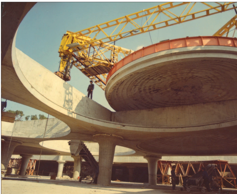
39. L. Moretti, Podziemny parking Villa Borghese (1965-1972), montaż elementów prefabrykowanych, wykonanych poza terenem budowy. Archivio Centrale dello Stato, Rzym 39. L. Moretti, Villa Borghese underground Parking Garage (1965-1972), views of the assembling of prefabricated elements, built outside the construction site. Archivio Centrale dello Stato, Rome
