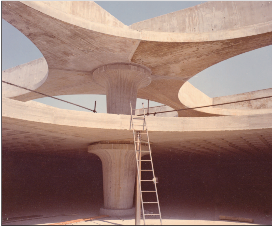
40. L. Moretti, Podziemny parking Villa Borghese (1965-1972), montaż elementów prefabrykowanych, wykonanych poza terenem budowy. Archivio Centrale dello Stato, Rzym 40. L. Moretti, Villa Borghese underground Parking Garage (1965-1972), views of the assembling of prefabricated elements, built outside the construction site. Archivio Centrale dello Stato, Rome
