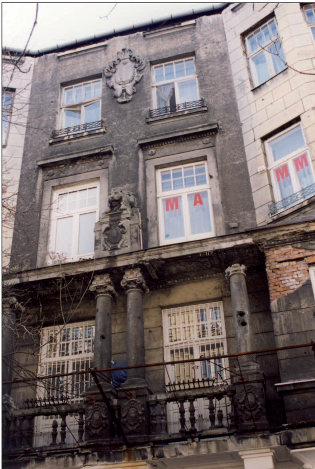
54. Kamienica przy ul. Emilii Plater 25 (ok. 1910). Przed remontem. Fot. J. Roguska 1998
