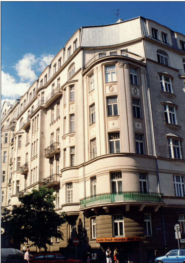
45. Kamienica przy ul. Nowogrodzkiej 40 (1910-11). Fot. J. Roguska 2003 45. Tenement house at 40 Nowogrodzka St. (1910-11). Photo J. Roguska 2003
