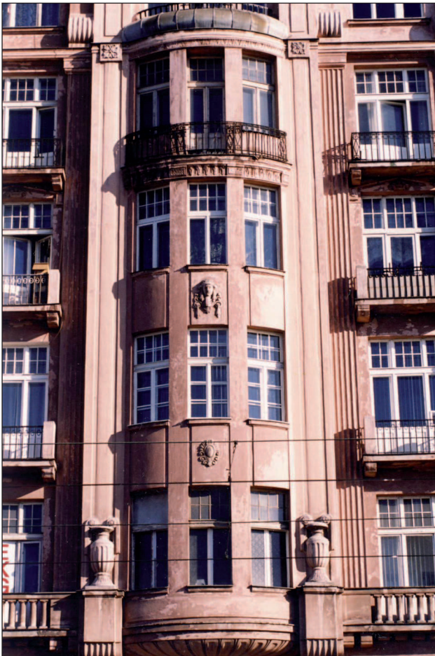
31. Okna w kamienicy w Alejach Jerozolimskich 49 (1913). Fot. J. Roguska 2003
