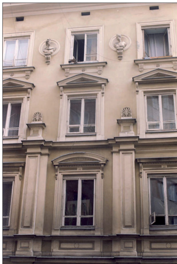
37. Fragment elewacji domu przy ul. Zgoda 3 (1874-75). Fot. J. Roguska 2001 37. Fragment of elevation of the house at 3 Zgoda St. (1874-75). Photo J. Roguska 2001
