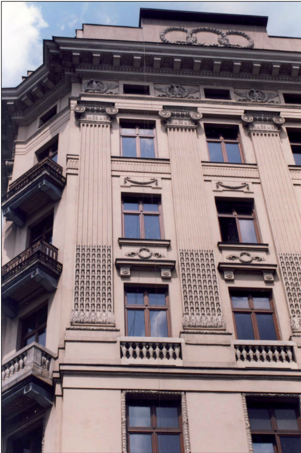
52. Fragment elewacji kamienicy dawniej E. Raczyńskiego przy pl. Małachowskiego – ul. Mazowiecka, róg Traugutta. Fot. J. Roguska 2003
