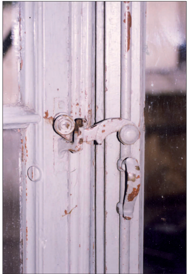
34. Środkowy fragment mechanizmu zawrotnicy (bagnetsztangi) okna na klatce schodowej w kamienicy przy ul. Marszałkowskiej 41. Fot. J. Roguska 2003
