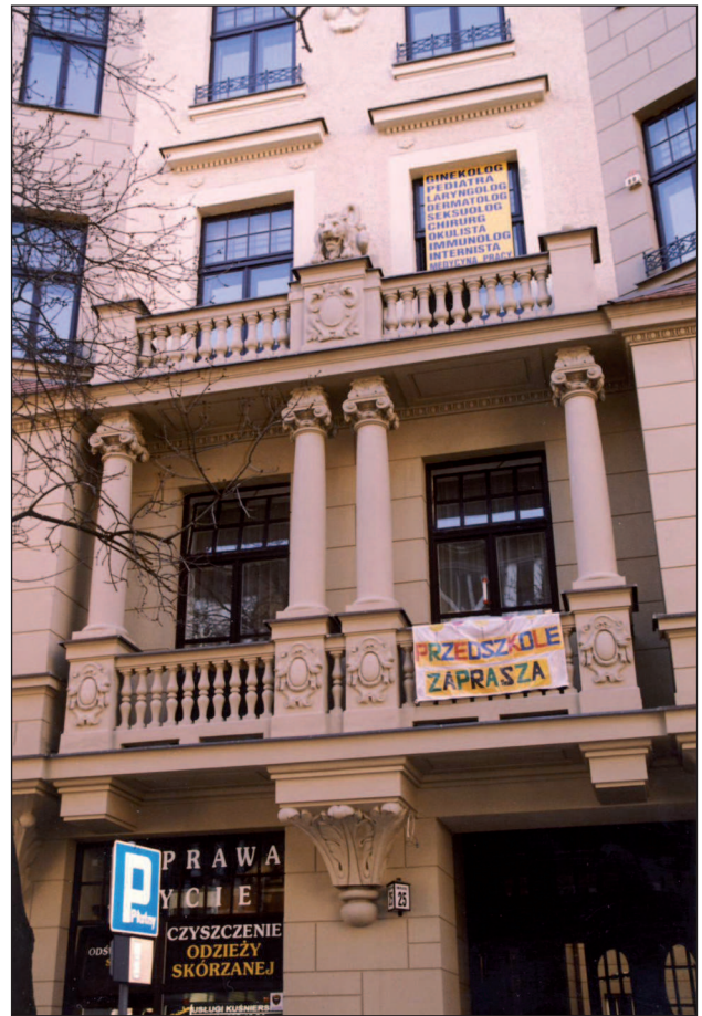
55. Kamienica przy ul. Emilii Plater 25 (ok. 1910). Po remoncie. Fot. J. Roguska 2003
