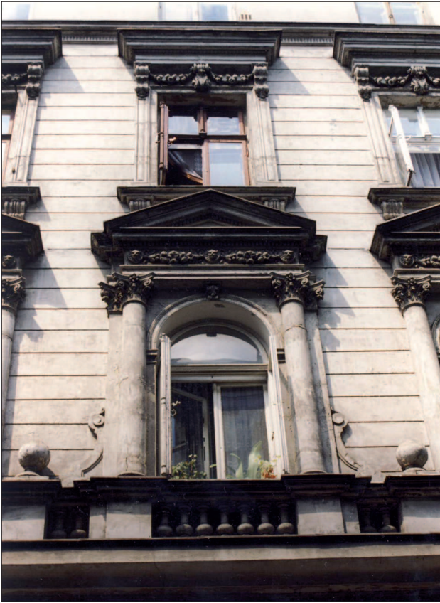
15. Okna kamienicy przy ul. Hożej 42 (część frontowa – 1892-93). Fot. J. Roguska 2003
