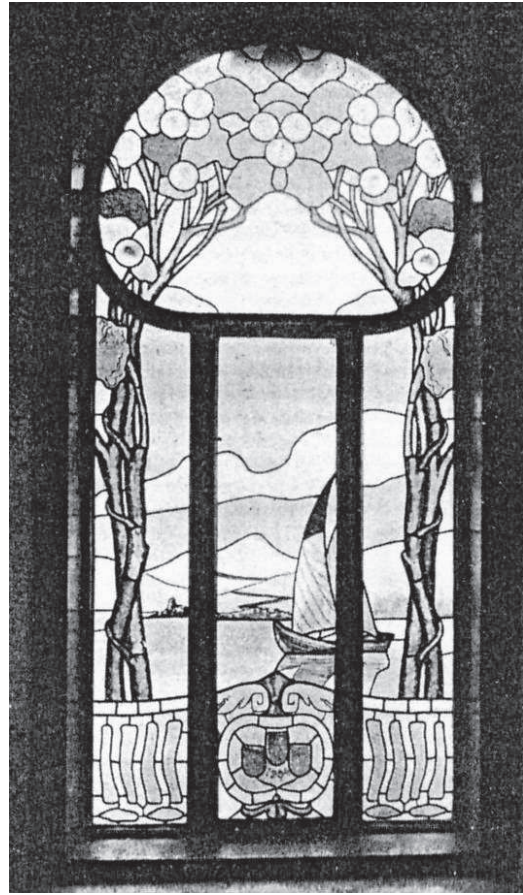
24. Okno klatki schodowej w kamienicy przy ul. Służewskiej 3 (nie istnieje). „Przegląd Techniczny”, 1905, nr 9 24. Window of the staircase in the tenement house at 3 Służewska St. (does not exist). “Przegląd Techniczny”, 1905, no 9
