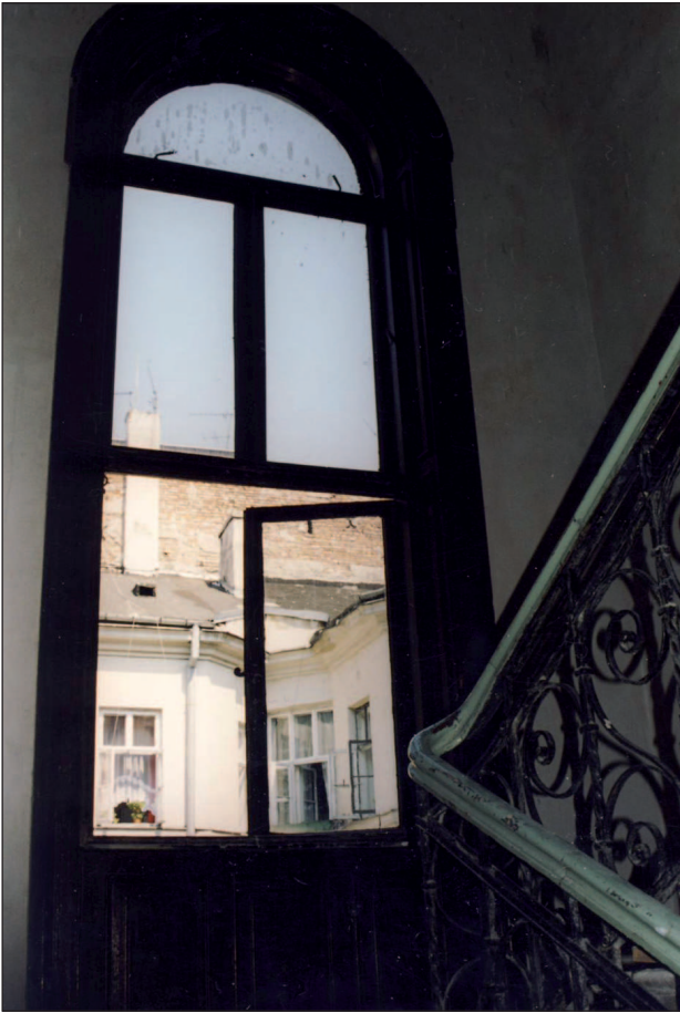
26. Okno klatki schodowej na ostatnim piętrze kamienicy przy ul. Nowogrodzkiej 10 (1892-93). Fot. J. Roguska 2003
