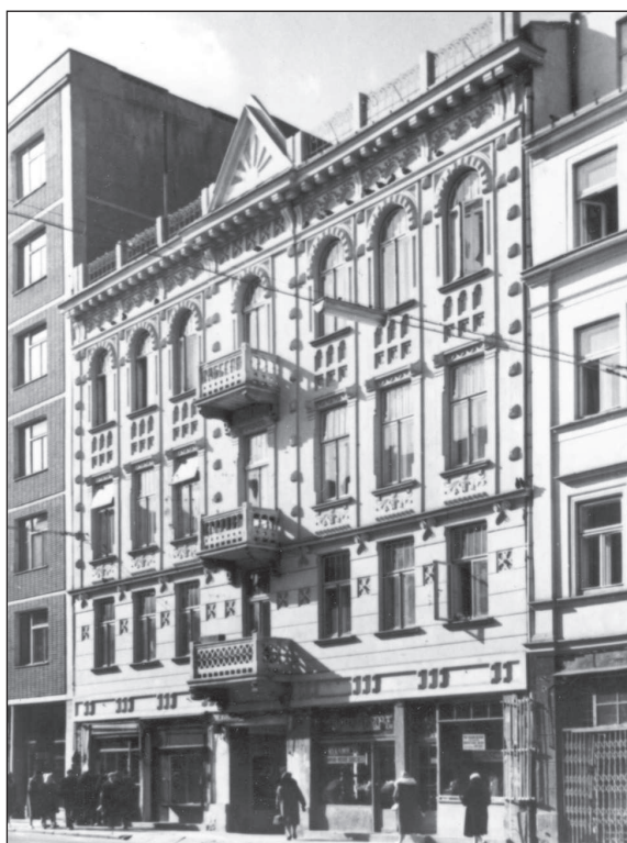
5. Fasada kamienicy przy ul. Chmielnej 30. Stan w roku 1961 roku. Jeszcze z oryginalną stolarką okien, otwieranych na zewnątrz i pierwotną, ciemną kolorystyką zewnętrzną. Fot. A. Zborski, 1961
