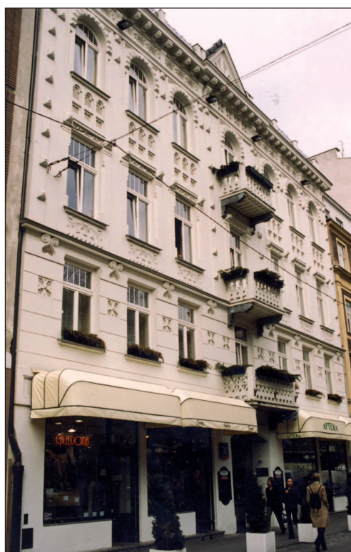
7. Fasada kamienicy przy ul. Chmielnej 30 po generalnym remoncie, z nowymi uchylnymi do wewnątrz oknami, w barwie białej. Fot. J. Roguska 2003
