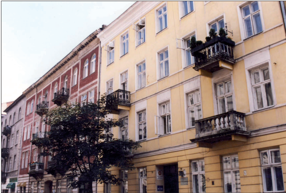
14. Kamienice przy ul. Wilczej 15 z 1885 r. (pierwsza z prawej) i dalej nr 13 i 11 z 1886 r. Utraciły dekorację fasad w czasie II wojny. Okna otwierane na zewnątrz – ościeżnicowe, drzwi balkonowe otwierane do wewnątrz, półskrzynkowe lub skrzynkowe. Nadślepię okien kamienicy przy ul. Wilczej 15 – dwuskrzydłowe. Fot. J. Roguska 2003
