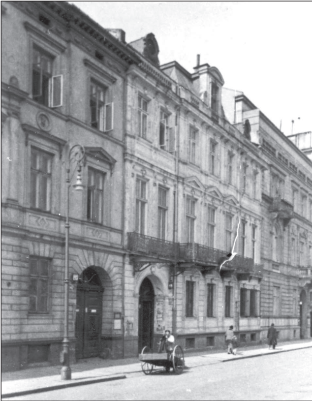
12. Kamienice przy ul Zielnej (od lewej) 47, 49, 51. AMWKZ, Zbiór Referatu Gabarytów 12. Tenement houses at 47, 49 and 51 Zielna St. (from the left). AMWKZ, Volumetric Section collection
