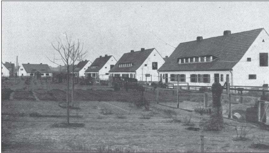
21. Złotniki, domy przy placu Kaliskim. Fot. 1920. Proj. E. May, 1919. Źródło: SH, 1(1920), po z. 10, zeszyt specjalny, il. 9
