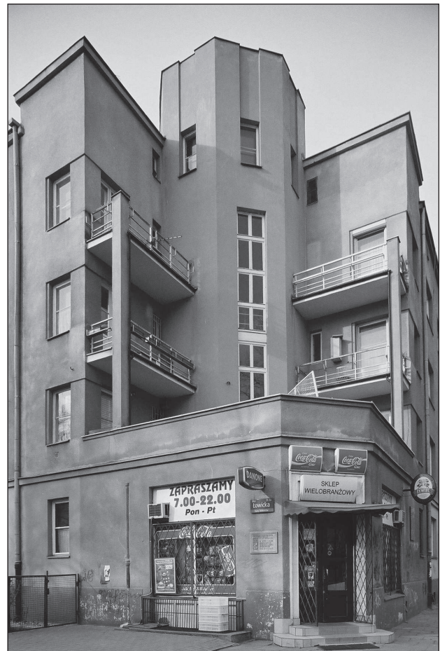
5. Warszawa, ul. Fałata 6, widok ze skrzyżowania ulic Rakowieckiej i Łowickiej. Fot. Autor 5. Warsaw, 6 Fałata street, view from the crossroads of Rakowiecka and Łowicka. Photo: Author
