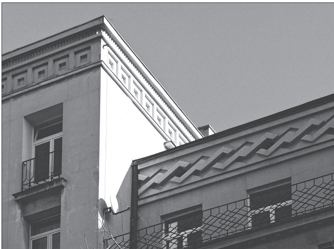
16. Warszawa, Aleja Szucha 2/4, detal elewacji. Fot. Autor 16. Warsaw, 2/4 Szucha Avenue, facade detail. Photo: Author
