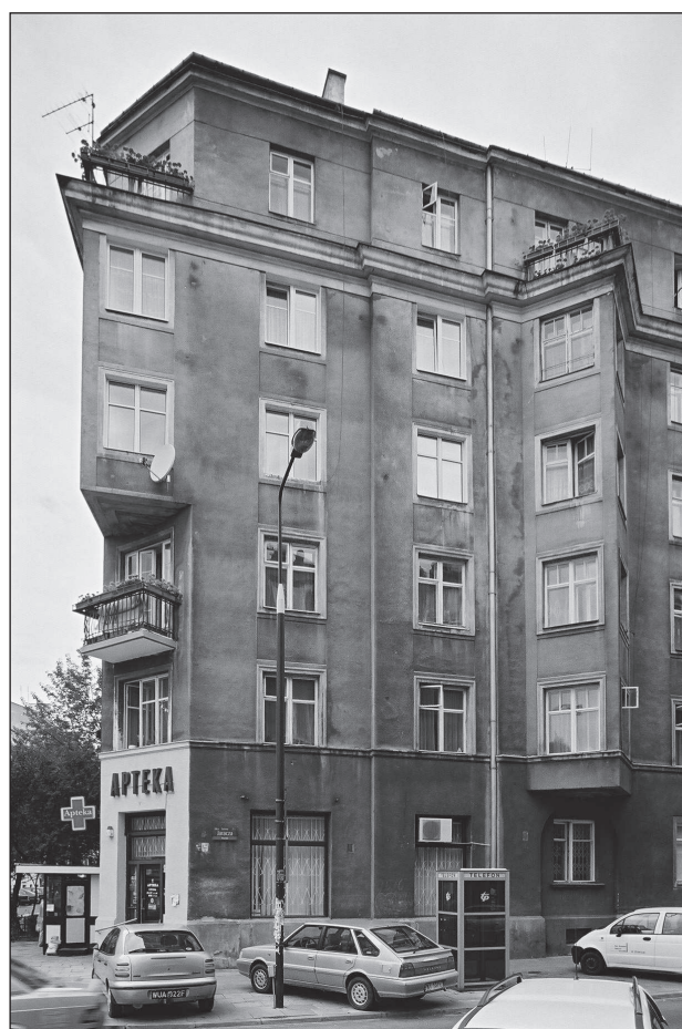
2. Warszawa, ul. Dobra 2, narożny wykusz od strony ul. Jaracza. Fot. Autor 2. Warsaw, 2 Dobra street, corner bay window from Jaracza street. Photo: Author
