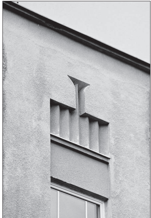
20. Warszawa, ul. Kozińskiego 6/8/10/12, detal zwieńczenia klatki schodowej od strony podwórza. Fot. Autor 20. Warsaw, 6/8/10/12 Kozińskiego street, detail of the staircase finial from the courtyard. Photo: Author
