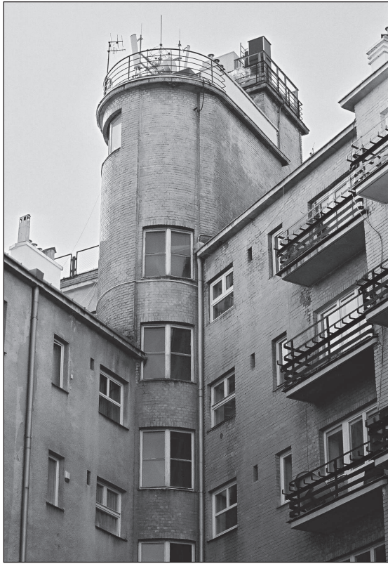
13. Warszawa, Aleja Szucha 16, wieża klatki schodowej od strony podwórza. Fot. Autor 13. Warsaw, 16 Szucha Avenue. staircase tower from the courtyard. Photo: Author
