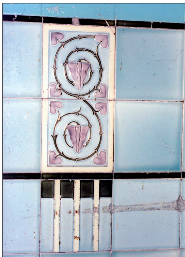
50. Fragment okładziny ścian płytkami glazurowanymi w przejeździe bramnym kamienicy przy ul. Noakowskiego 12. Fot. Autorka 2003
