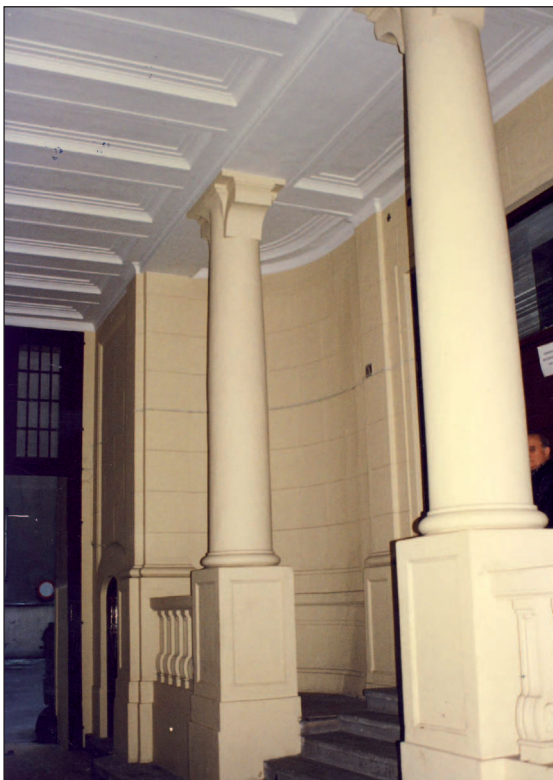
42. Schody wyrównawcze w przejeździe kamienicy przy ul. Nowogrodzkiej 40. Fot. 2003 42. Levelling stairs in the passage of the tenement house at 40 Nowogrodzka. Photo 2003
