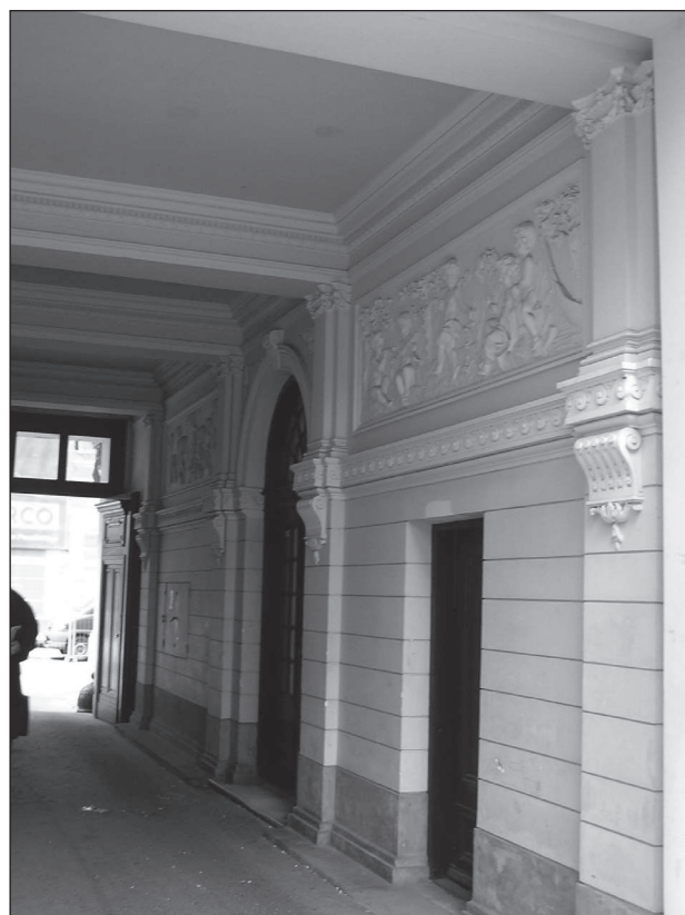
29. Warszawa, ul. Mokotowska 50, kamienica, przejazd bramny. Fot. Autorka 2008
