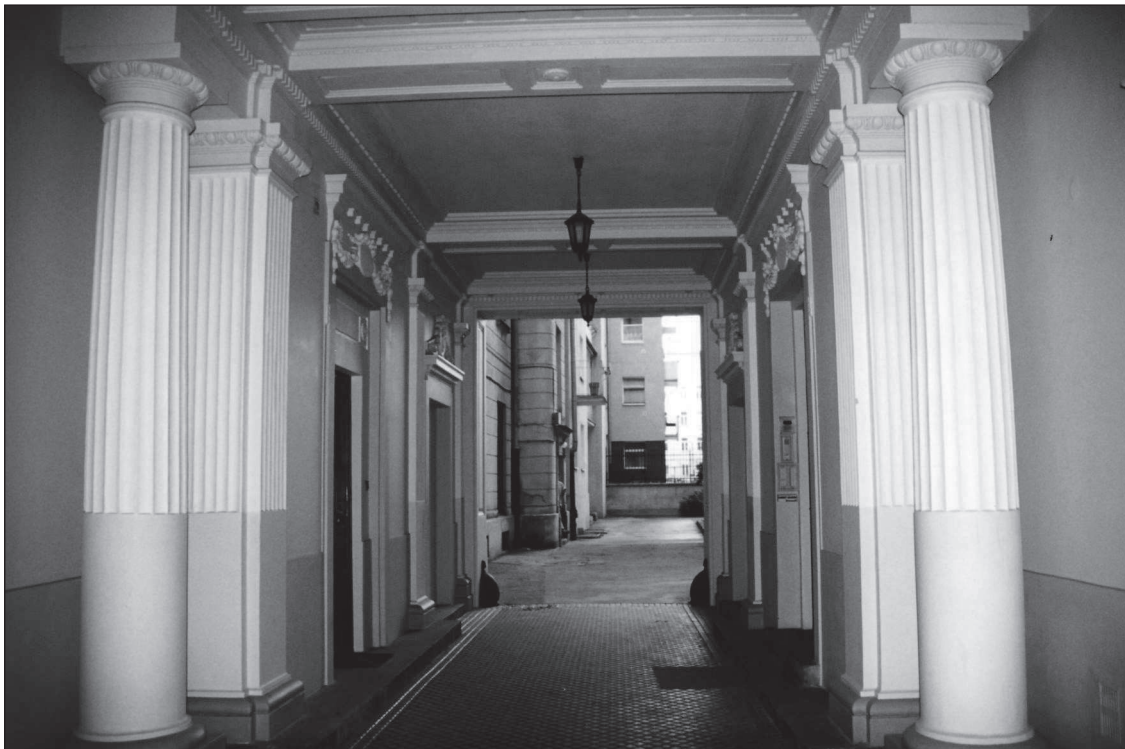
38. Warszawa, ul. Warecka 11, kamienica, przejazd bramny. Fot. Autorka 2003 38. Warsaw, 11 Warecka, tenement house, gate passage. Photo: Author 2003
