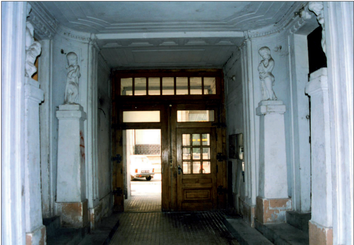
41. Warszawa, ul. Oboźna 45, kamienica, przejazd bramny. Fot. Autorka 2003 41. Warsaw, 45 Oboźna, tenement house, gate passage. Photo: Author 2003
