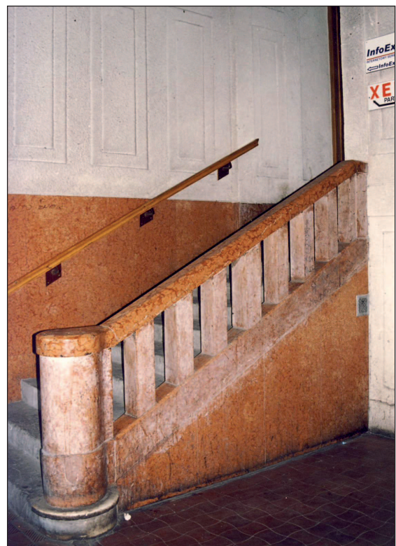
43. Rozszerzenie przejazdu bramnego – „ganek” wejściowy w kamienicy przy ul. Hożej 39. Fot. Autorka 2003 43. Expansion of the gate passage – entrance „porch” in the tenement house at 39 Hoża. Photo: Author 2003
