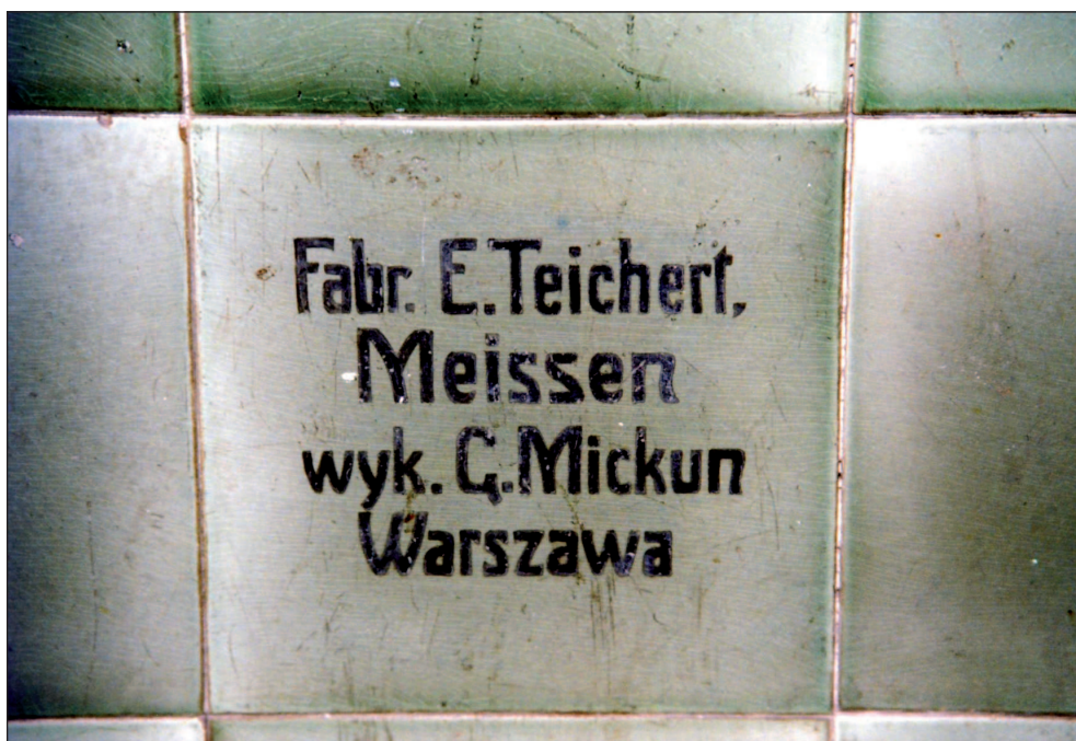
51. Płytką wskazująca producenta płytek glazurowanych na ścianach w przejeździe bramnym kamienicy przy ul. Noakowskiego 4. Fot. Autorka 2003 51. A tile indicating the tile producer on the walls of the gate passage of the tenement house at 4 Noakowskiego. Photo: Author 2003
