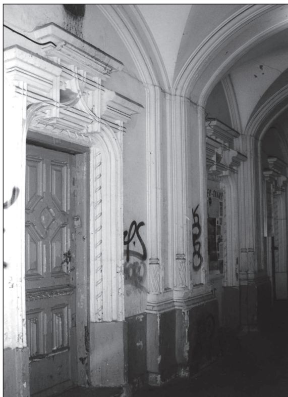
24. Warszawa, ul. Marszałkowska 66, kamienica, przejazd bramny. Fot. Autorka 2003 24. Warsaw, 66 Marszałkowska, tenement house, gate passage. Photo: Author 2003
