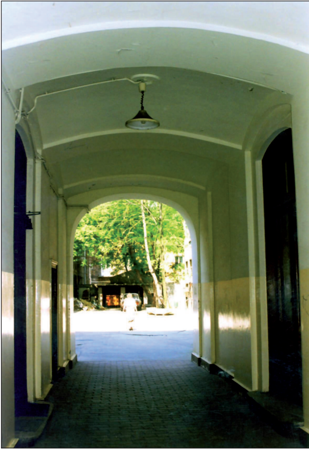
8. Warszawa, ul. Hoża 74, kamienica, przejazd bramny. Fot. Autorka 2003 8. Warsaw, 74 Hoża, tenement house, gate passage. Photo: Author 2003
