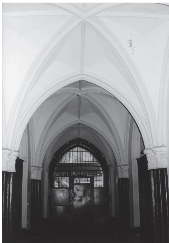
23. Warszawa, ul. Marszałkowska 72, kamienica, przejazd bramny. Fot. Autorka 2003 23. Warsaw, 72 Marszałkowska, tenement house, gate passage, Photo: Author 2003
