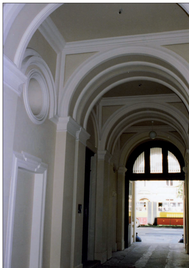
13. Warszawa, Aleje Ujazdowskie 39, kamienica pałacowa, przejazd bramny. Fot. Autorka 2005 13. Warsaw, 39 Aleje Ujazdowskie, palace tenement house, gate passage. Photo: Author 2005
