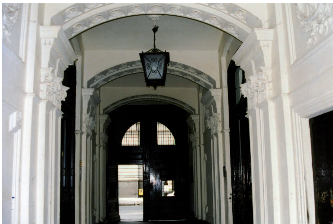
14. Warszawa, ul. Hoża 57, kamienica, przejazd bramny. Fot. Autorka 2003 14. Warsaw, 57 Hoża, tenement house, gate passage. Photo: Author 2003
