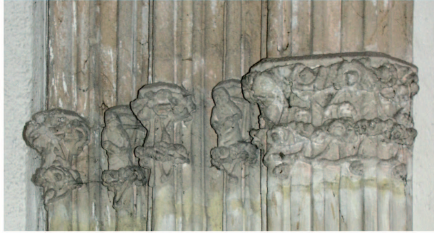
Wrocław - NMP na Piasku, strefa głowic portalu pd
