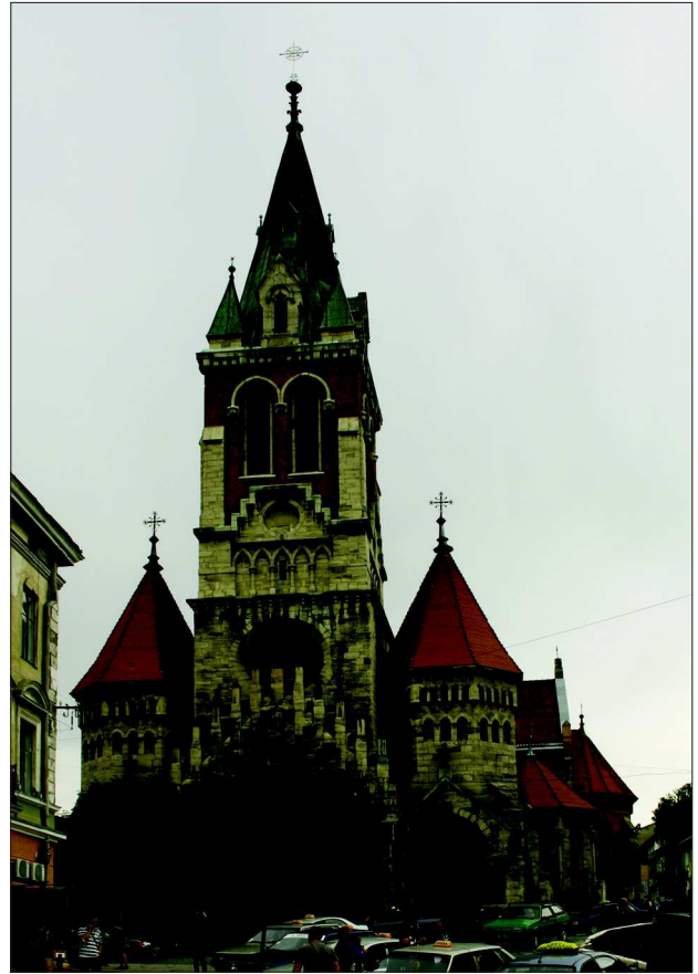
5. Kościół parafialny w Czortkowie, arch. J. Sas Zubrzycki. Fot. K. Stefański 5. Parish church in Czortków, designed by J. Sas Zubrzycki. Photo by K. Stefański
