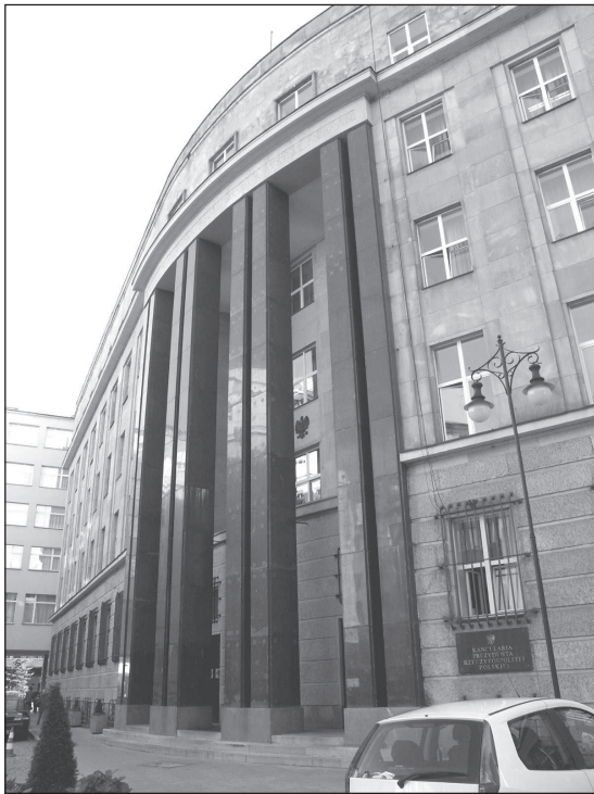
25. Warszawa, gmach d. Izby Przemysłowo-Handlowej w Warszawie przy ul. Frascati 2, róg Wiejska, stan obecny.
