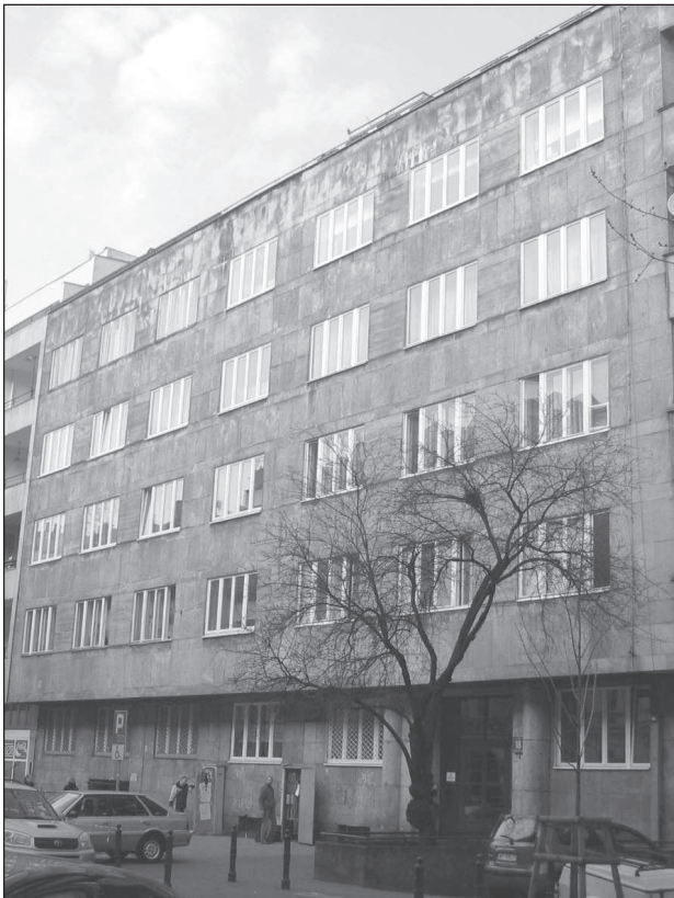
19. Warszawa, kamienica przy ul. Wiejskiej 18, stan obecny. Fot. Autorka, 2009 19. Warsaw, a tenement house at 18 Wiejska St., present day. Photograph: Author, 2009
