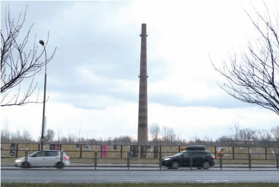
1. Widok kominu od ul. Radzywińskiej, fot. Autor 1. View of the chimney from Radzywińska Street, photo: Author
